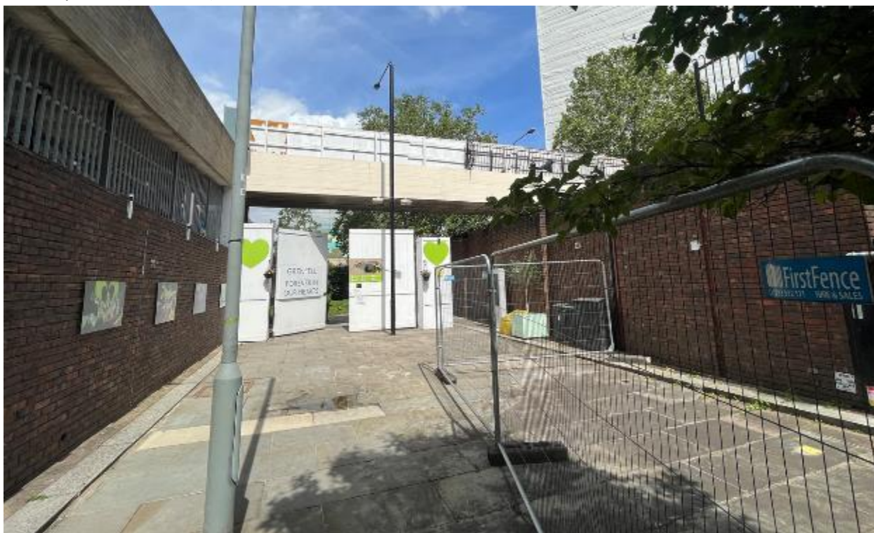
Fotografía del emplazamiento 2: Vista por encima de Station Walk en la entrada protegida del emplazamiento (06/07/23)
